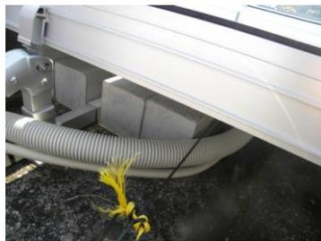
写真・コンクリートブロックを置いて抑え込んで設置した太陽光パネル
